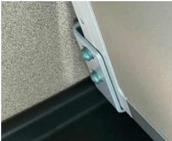
Abbildung 2: Gelenk-Auflager
