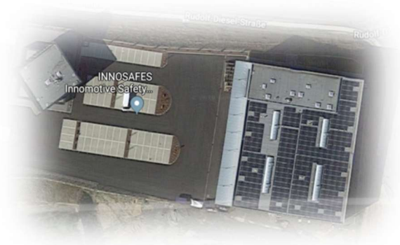
PV-Anlage mit 170 kWp auf dem Produktionsgebäude
